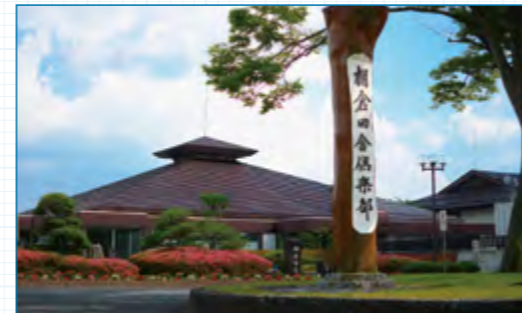
棚倉田舎倶楽部外観
