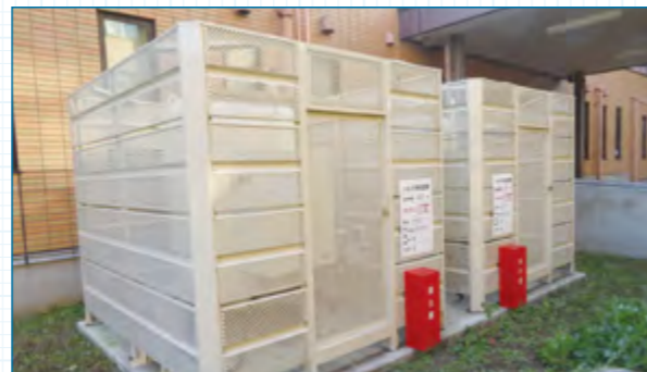
LPガスバルク2基本を設置
